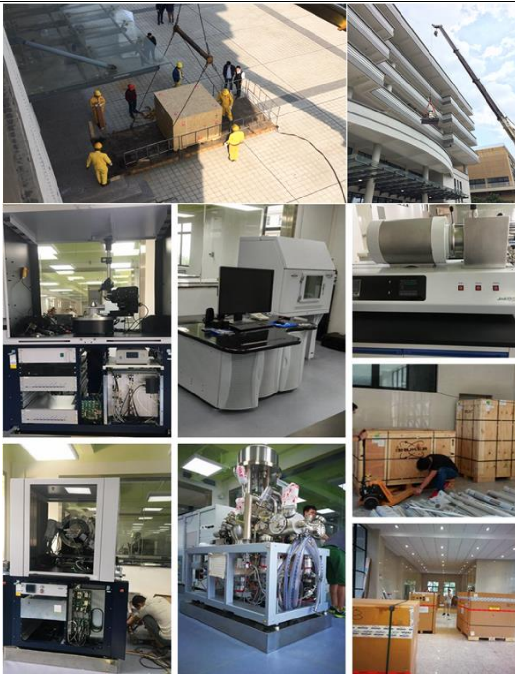
设备近场和安装调试现场
